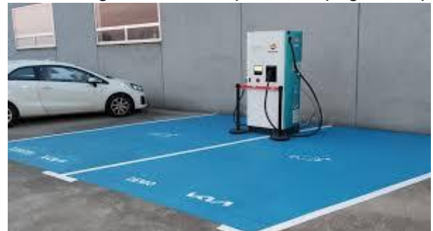
Figura 4. Detall pintat placa d'aparcament vehicle de recàrrega elèctric
